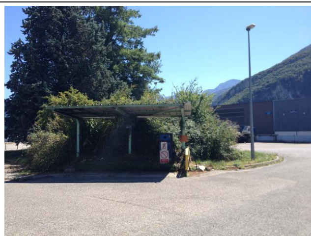
Poste de distribution des chariots élévateurs
